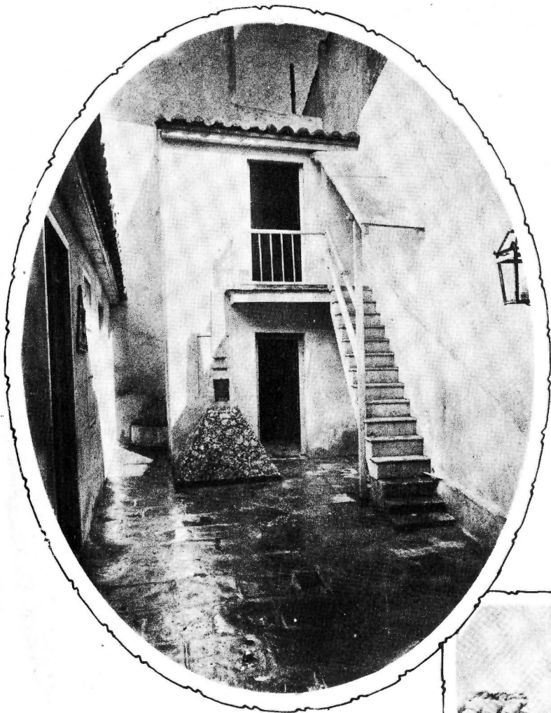
El patio de la casa, según su estado actual.
